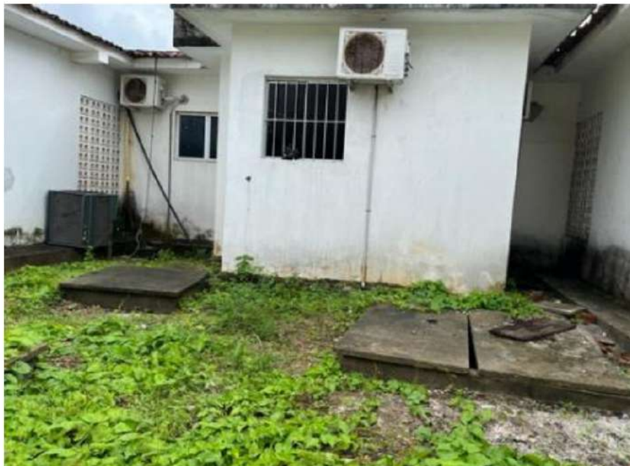
Figura 12 – vista das caixas elétricas.
